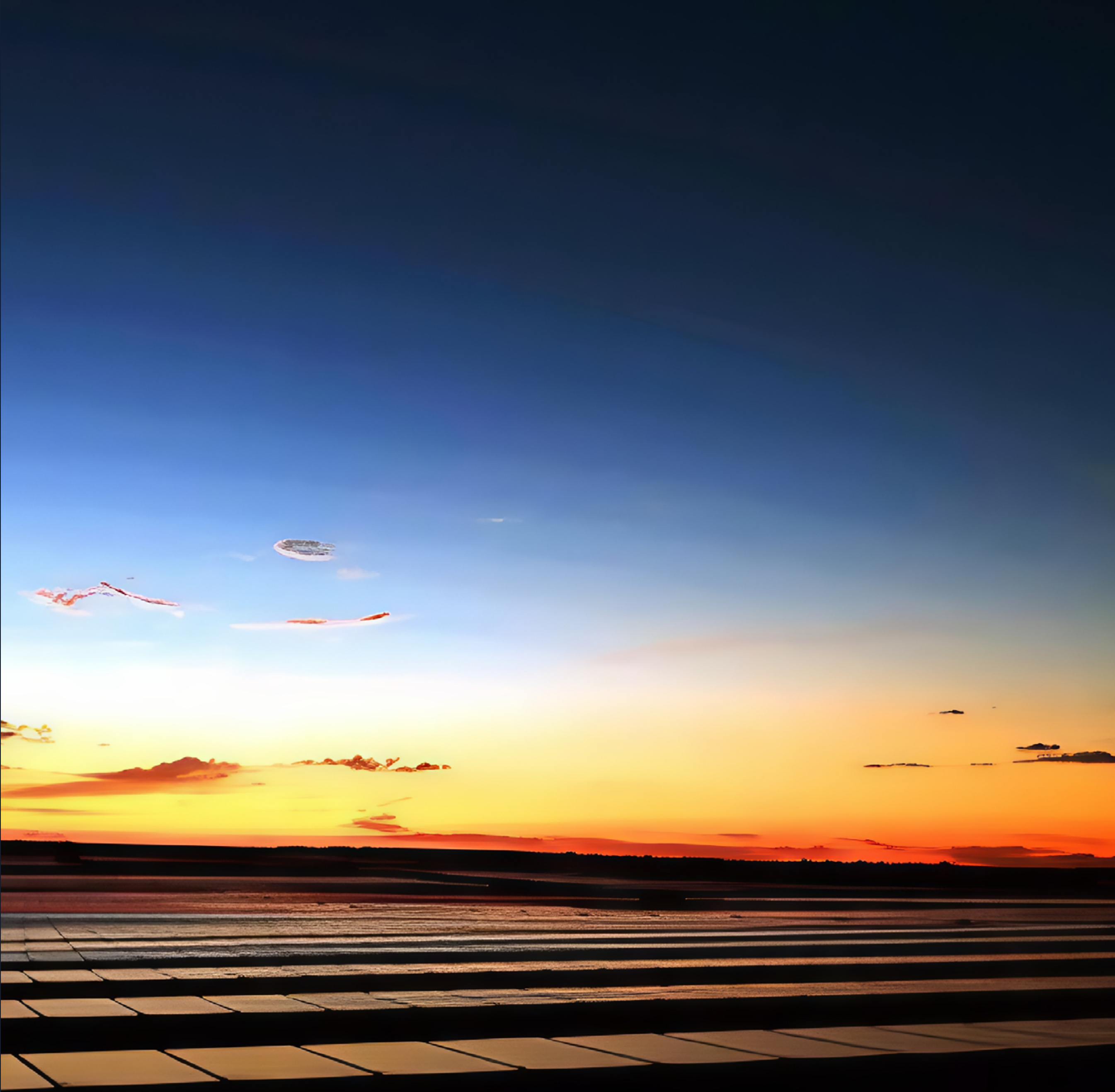
Planta solar fotovoltaica Kaixo Solar, Chihuahua, México
